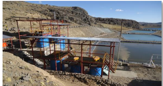
Planta de Tratamiento de Vertimiento: Beatricita
