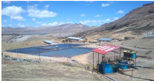
Planta de Tratamiento de Vertimiento: Pampamachay
