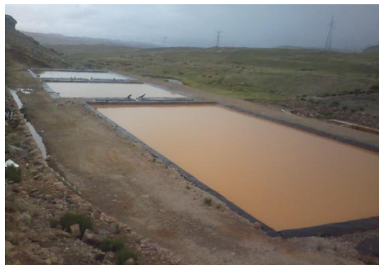
Tratamiento Pasivo de Vertimiento en Astohuaraca
