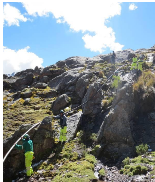
Instalación de tubería para distribución de agua para consumo Comunidad Campesina de Choclococha – Zona Palomo
