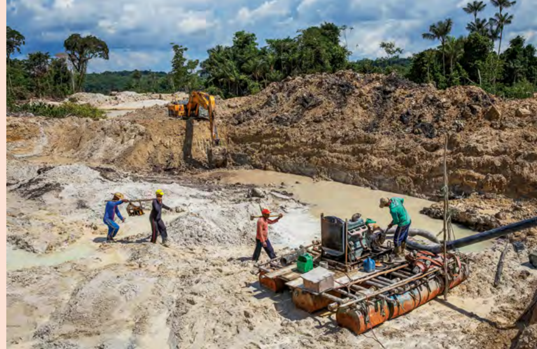
Una excavadora remueve la tierra preparando el barranco, mientras los hombres reparan una bomba de agua para trabajar con un chorro en el río Rato, un afluente del río Tapajós, Pará, Brasil. Lalo de Almeida, 2018.
