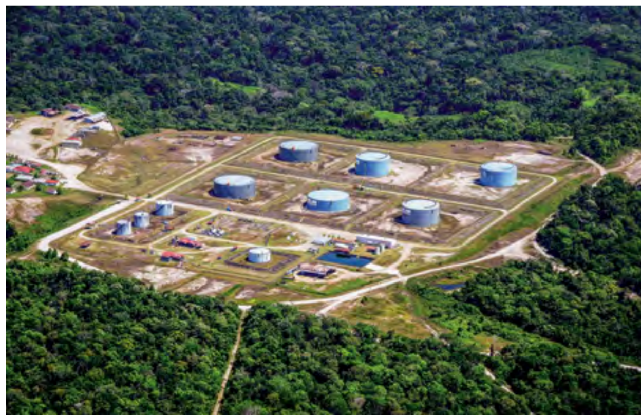
Instalaciones del lote de hidrocarburo 116 que se superpone al territorio tradicional de los pueblos Wampis y Awajún. Región Loreto, Perú. Álvaro Del Campo / The Field Museum, 2011.
