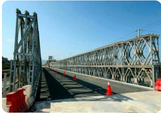
Creación del puente Kutuctay y accesos, provincia de Cotabambas
