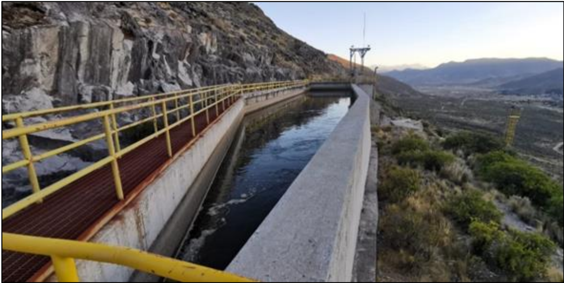
Fotografía 9.1.1 Cámara de carga de la C.H. Huancarama
