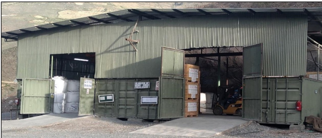
Figura 9.1. Almacén de cianuro y cal
