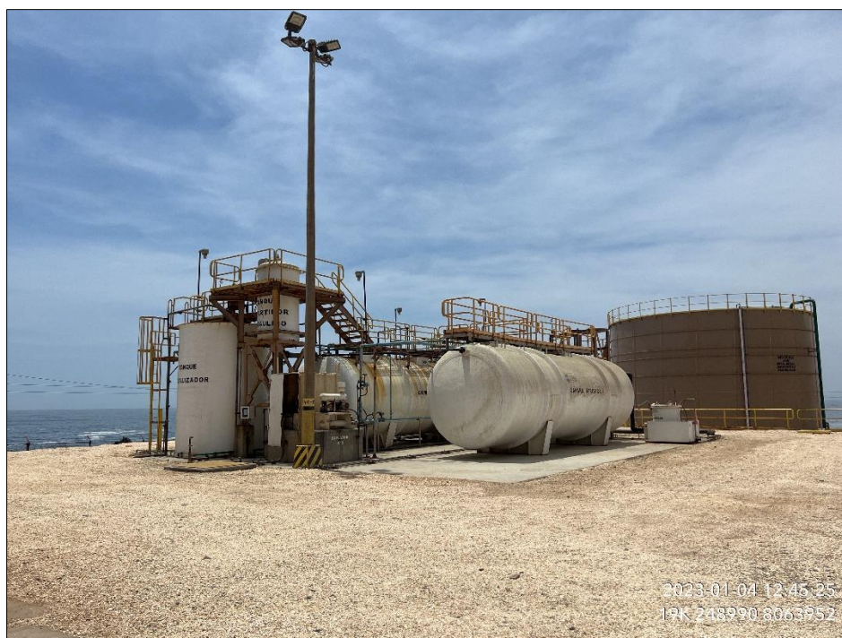
Figura 9.3.2.2- 1 Vista actual de la PTAR
