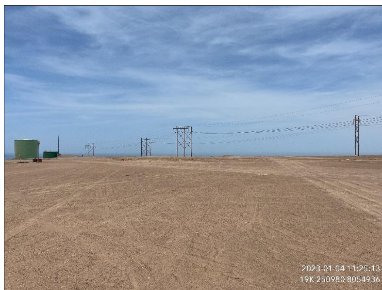
Figura 9.7.2.1- 1 Vista actual de las instalaciones para la producción de compostaje
