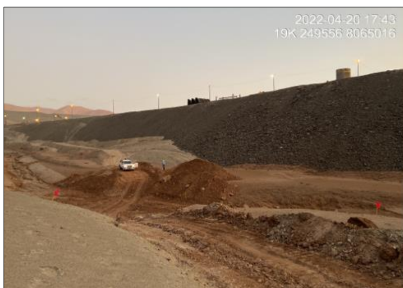
Figura 9.7.2.3-3 Vista actual de ubicación para los puntos de control geotécnicos (P3 y P4)
