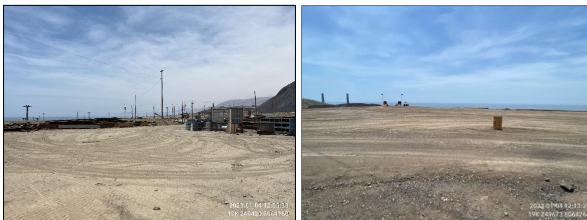
Figura 9.7.2.3-2 Vista actual de ubicación para los puntos de control geotécnicos (P1 y P2)
