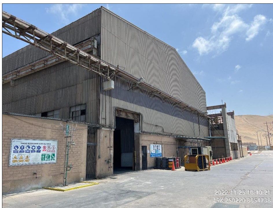
Figura 9.3.2.1-2 Vista actual de la Planta Electrolítica
